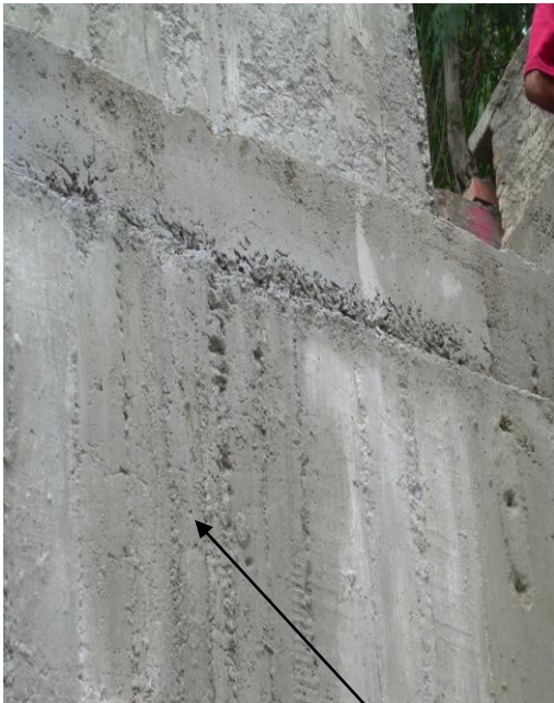
Aspecto irregular en el acabado de las caras de los muros laterales
