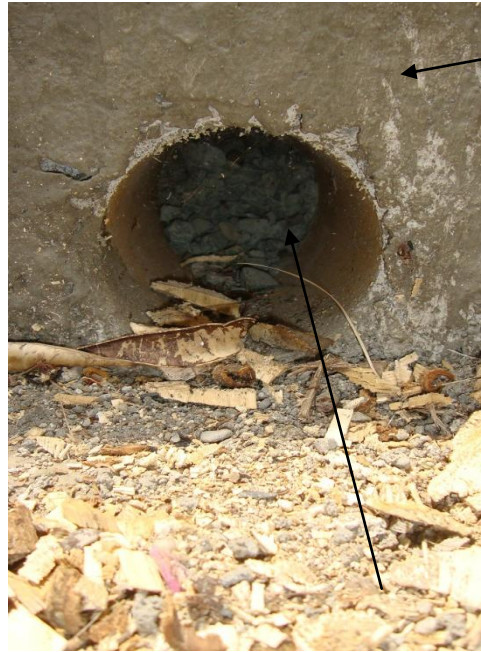
Muro de contención
