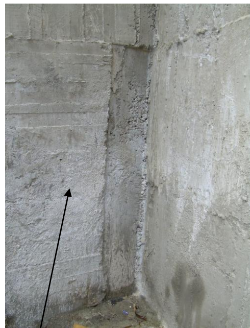
Aspecto irregular en el acabado de las caras de los muros laterales
