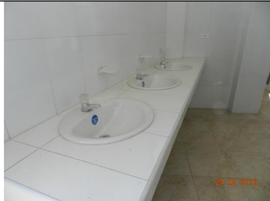
Camerino damas. Lavamanos de cerámica, mesón en concreto, enchapado cerámica,
