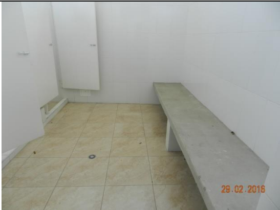
Camerinos hombres, banca en concreto, piso en baldosa de cerámica, pintura de muros, divisiones metálicas de baños
