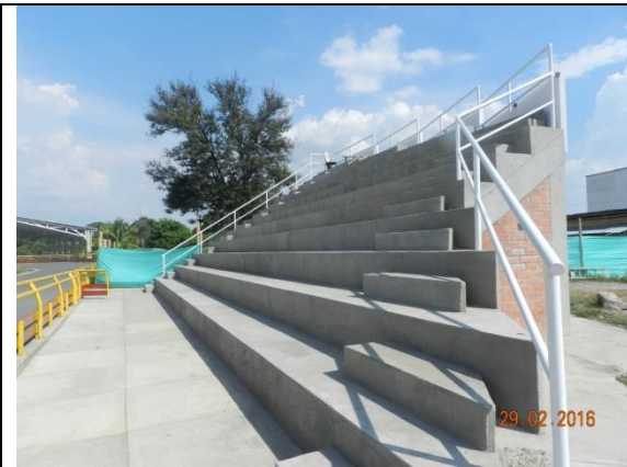
Gradería en concreto, baranda metálica, pintura acabado esmalte, andenes en concreto
