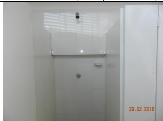
Camerino damas. Ducha, enchape cerámica, divisiones metálicas
