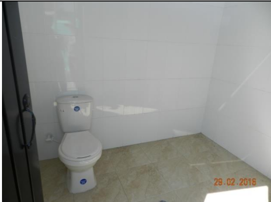
Baño intermedio, enchapes de muros y piso en cerámica. Puerta metálica
