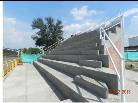
Andenes en concreto en acceso a gradería sobre los camerinos
