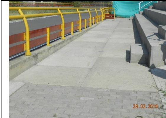
Andenes en concreto en acceso a gradería sobre los camerinos
