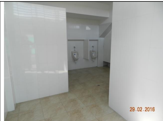
Camerinos hombres, piso en baldosa de cerámica, pintura de muros
