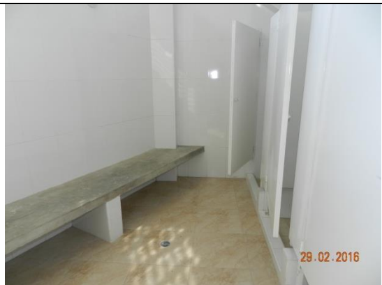
Camerinos damas, banca en concreto, piso cerámica, divisiones metálicas para baños
