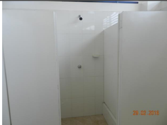
Camerinos hombres, ducha, enchape cerámica, divisiones metálicas
