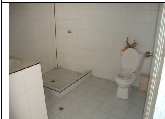
Enchape de cerámica en baños, aparatos sanitarios, instalaciones hidráulicas y sanitarias
