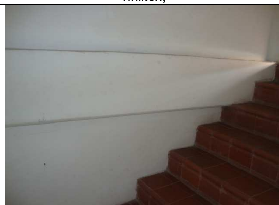
Vigas y escalera en concreto reforzado
