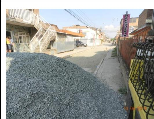
Intervención en sitios más críticos. Base granular compactada. Acopio de grava triturada para concreto
