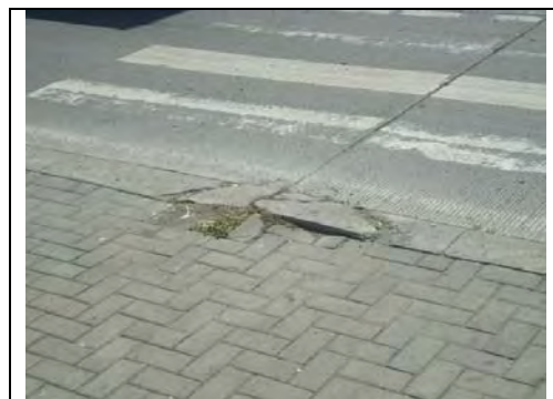
CII5 – Cra38 – 80: Hueco en losa, carril sur norte.
