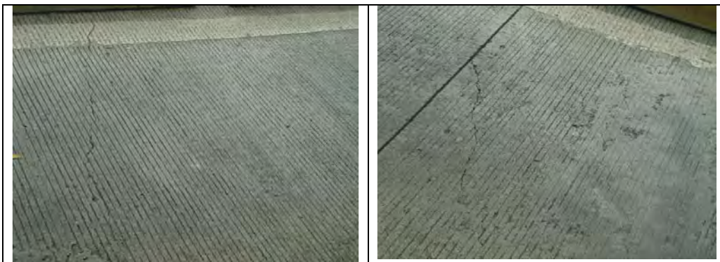
Cra100 frente a portería 5 de Unicentro: Fisura de losa, junto a una cámara de registro de alcantarillado y separadores de vía en mal estado, carril norte sur.
