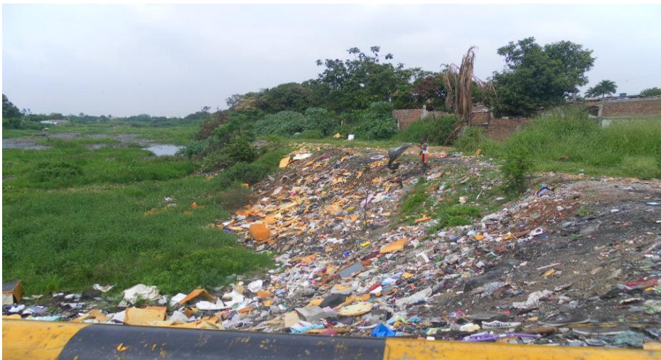
Disposición inadecuada de escombros de Laguna Pondaje El
