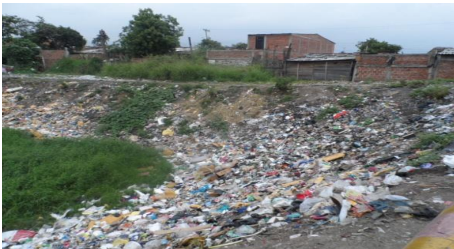
Disposición inadecuada de residuos sólidos sobre taludes del humedal el Pondaje
