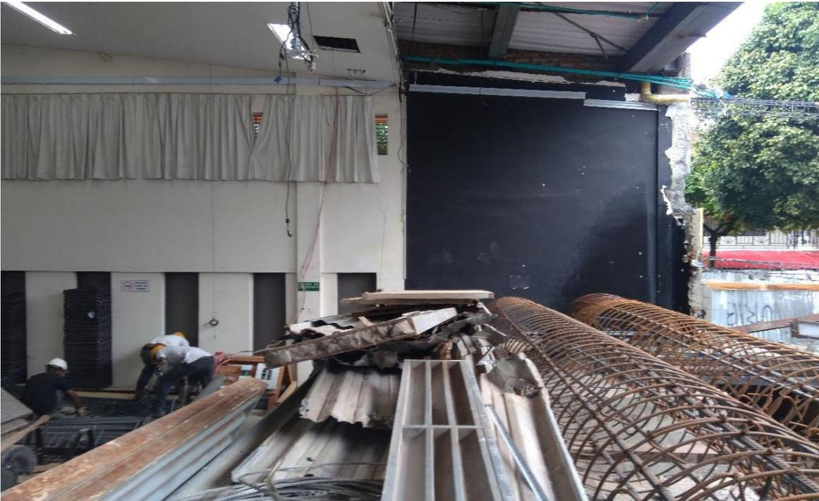
Armado de refuerzo para pilotes
