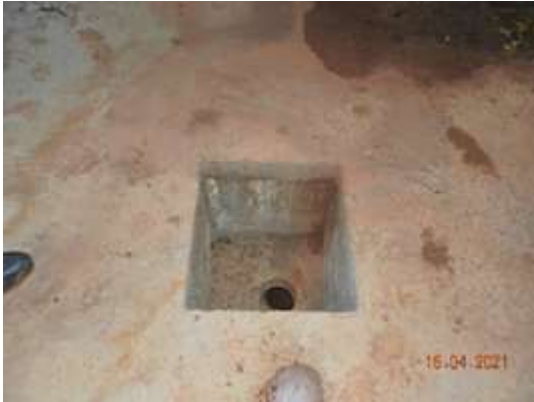
Tanque Vallejo, La Buitrera. losa de piso en concreto fluido
