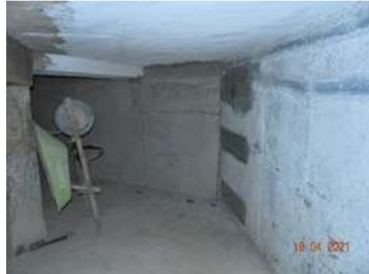
losa de piso en concreto fluido. Reforzamiento interior con fibras de carbono
