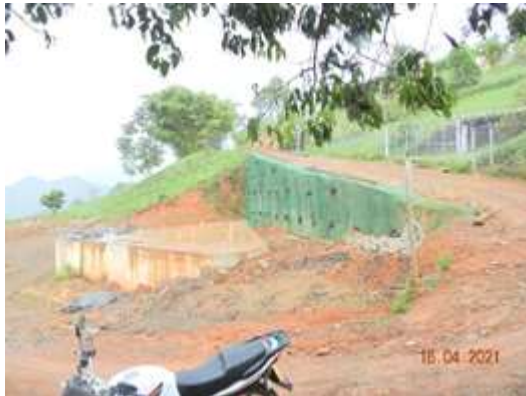
Tanque Vallejo, La Buitrera. Panorámica de la construcción. Tanque de almacenamiento en concreto reforzado y Muro en tierra mecánicamente estabilizada
