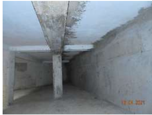
Tanque Vallejo, La Buitrera. Construcción de reforzamiento con columnas y zapatas de concreto reforzado al interior del tanque ancladas a la estructura existente
