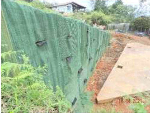
Tanque Vallejo, La Buitrera. Construcción de muro de protección del talud en tierra mecánicamente estabilizada
