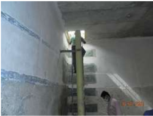
Tanque Vallejo, La Buitrera. Reforzamiento interior con fibras de carbono
