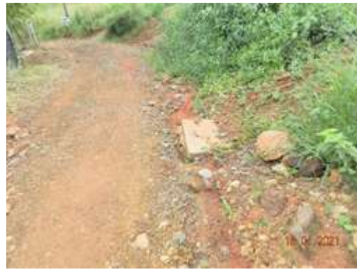
Tanque Vallejo, La Buitrera. Instalación de tuberías de desagüe y construcción de cajas de inspección
