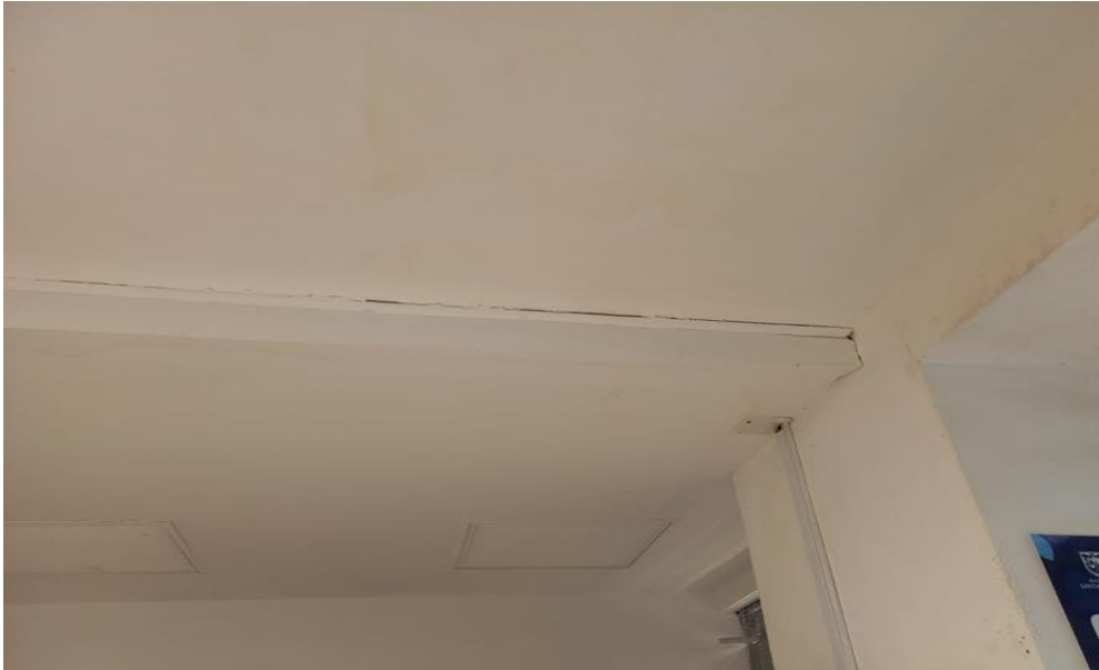
Dilatación de la junta.
