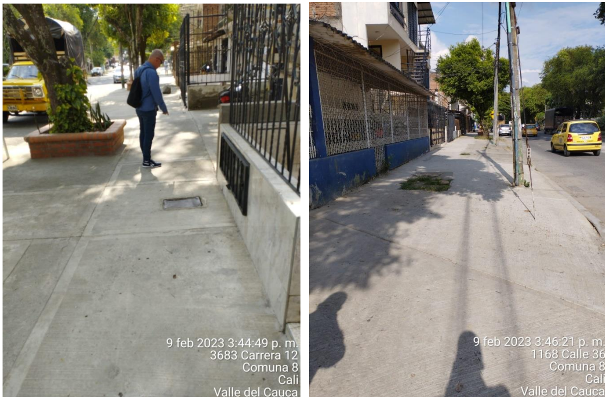
Fuente CGSC. Reposición de redes y andenes Barrio las Américas
