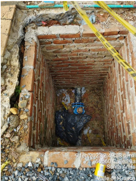
Fuente CGSC Cajas en mampostería con ladrillos pendiente instalación tapas
