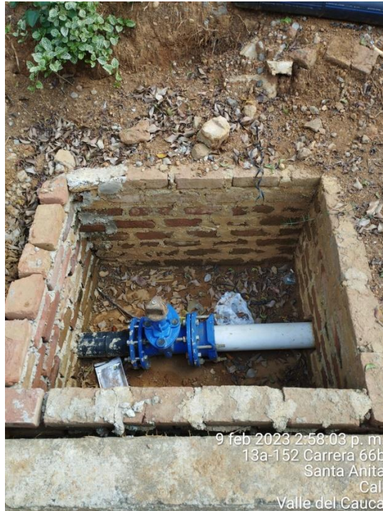
Fuente CGSC Cajas en mampostería con ladrillos pendiente instalación tapas
