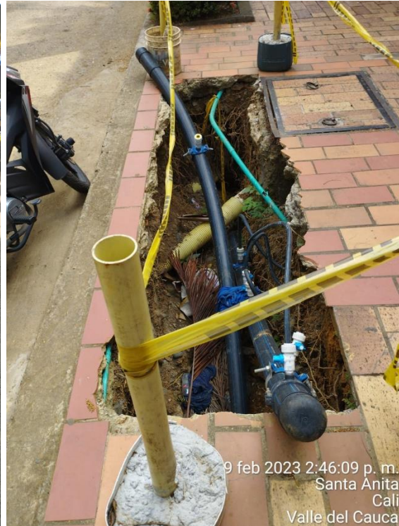
Fuente CGSC tramos de tuberías 4 pulgadas instalados y pendiente por hacer empalmes.
