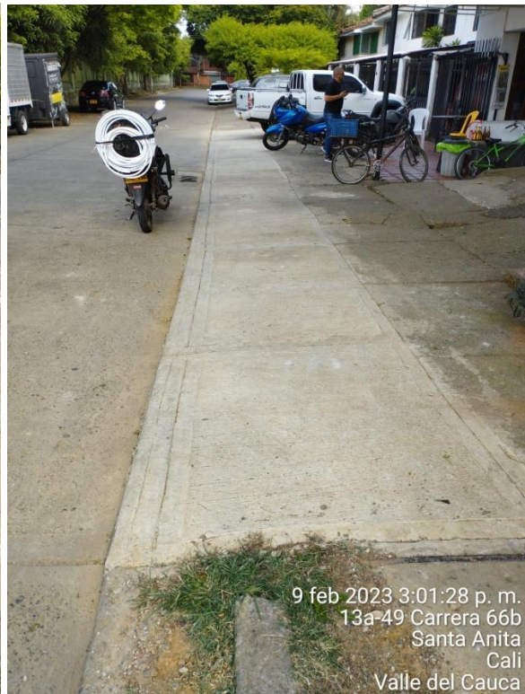
Fuente CGSC instalación tubería método de zanjas y reposición de andenes Bosques del Limonar
