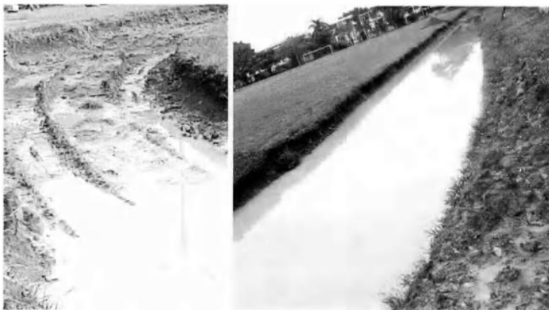
Ilustración 1 (situación inicial obra excavaciones)
