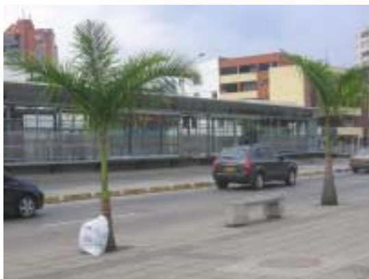
Estación de Parada Estadio
