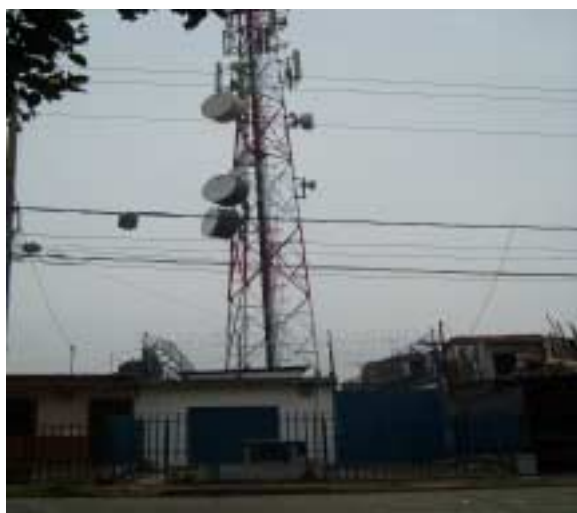
Fuente: Visita Realizada por los Funcionarios a las antenas Calle 26 No 46C-06
