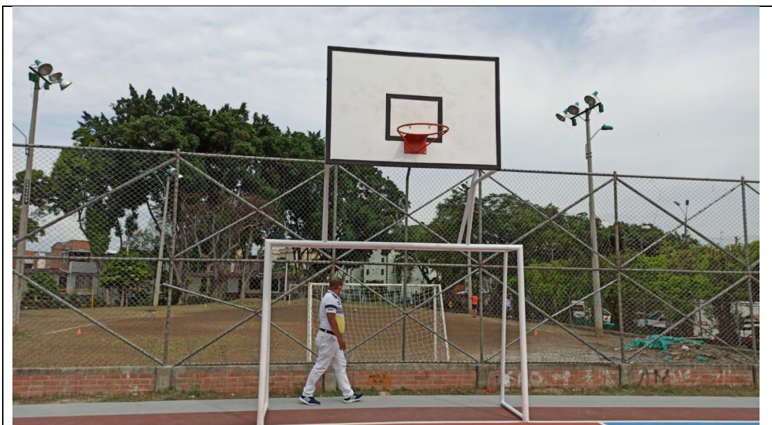
Cancha múltiple barrio Brisas de los Andes I. Porterías en estructura metálica, tablero de madera acabado pintura blanca, aro metálico.
