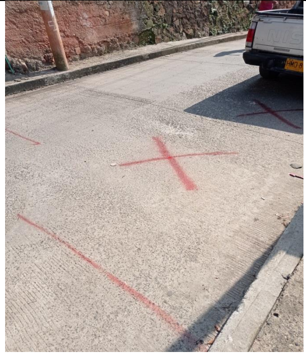
Paños del pavimento afectados en la Carrera 49B entre Calles 15 y 16 Oeste
