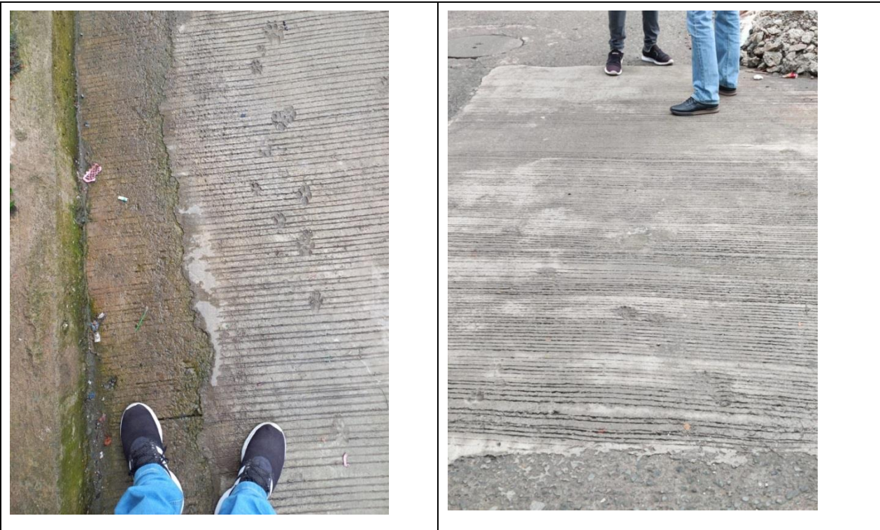
Registro de las huellas sobre el concreto fresco
