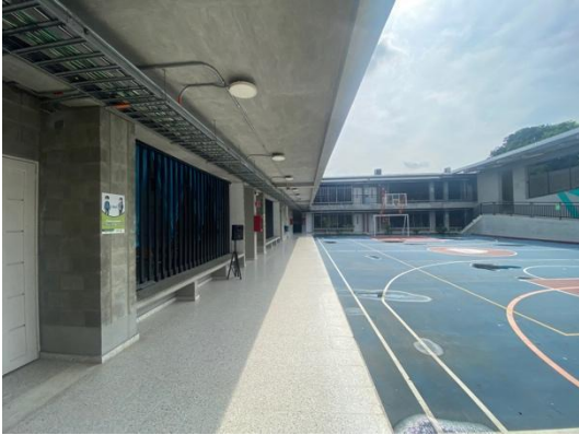
Pasillos internos en primer nivel
