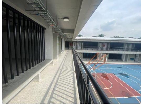
Pasillos internos con piso en baldosa y barandas metálicas en pasillo
