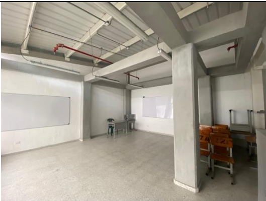
Espacios internos de salones con piso en baldosa, acabado en pintura sobre muros
