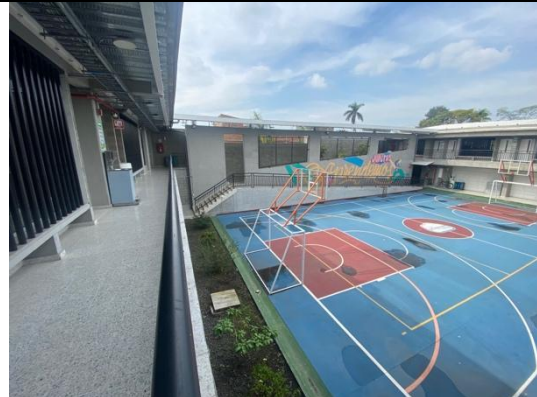
Pasillos internos de segundo nivel y cancha múltiple en primer nivel
