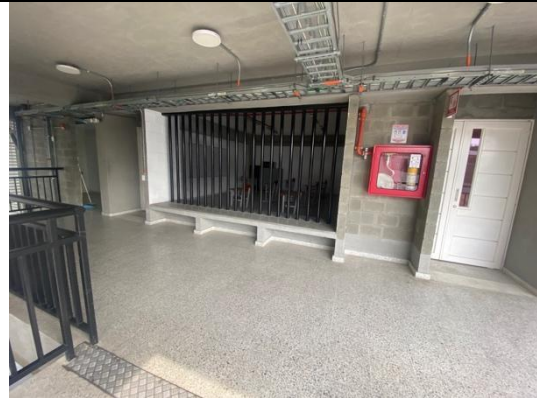
Fachada interna de salones, con puertas metálicas, ventanas con reja en tubería metálica que permite aireación permanente. Gabinete de emergencia, bandeja red Voz y datos y RCI
