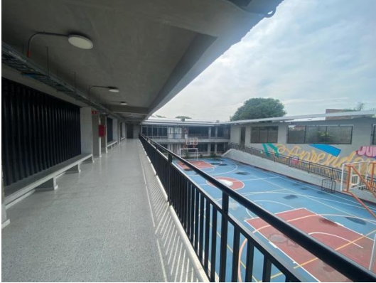
Pasillos internos con piso en baldosa, cielo raso e instalaciones eléctricas
