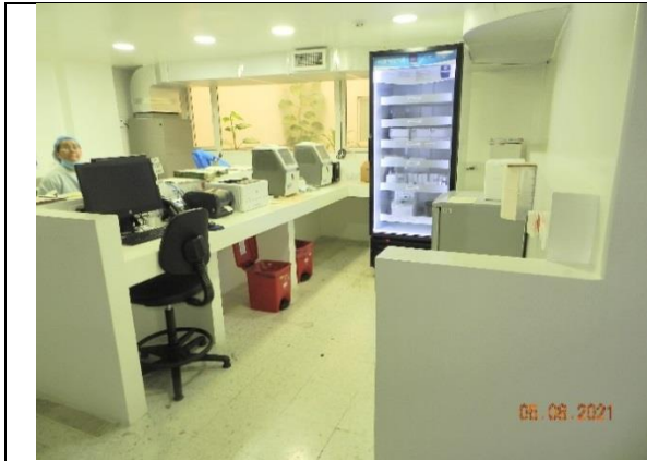
Clínica Unidos por la Vida. resanes de muros interiores, estuco y pintura, área de laboratorio
