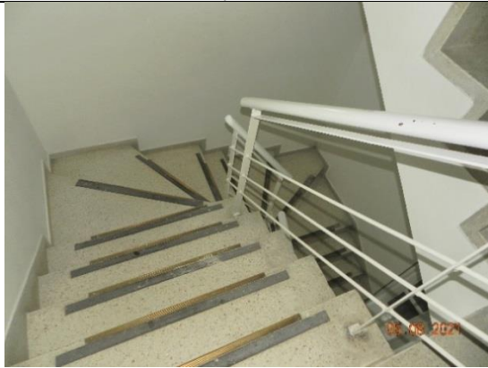
Clínica Unidos por la Vida, adecuación de pasamanos de escaleras
