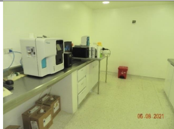
Clínica Unidos por la Vida. resanes de muros interiores, estuco y pintura, área de laboratorio, guarda escobas en cerámica piso-pared
