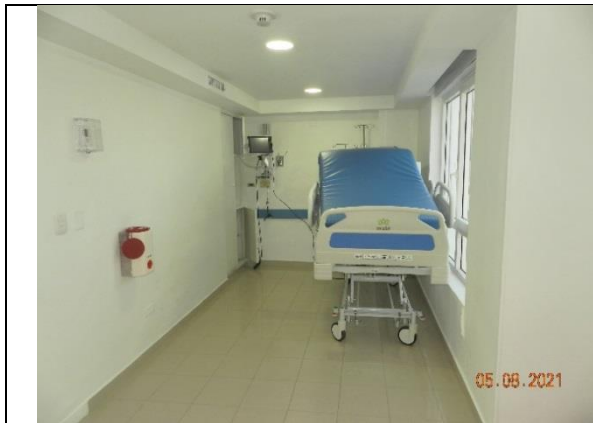
Clínica Unidos por la Vida, resanes de muros interiores, estuco y pintura, habitaciones, guarda escobas en cerámica piso-pared
