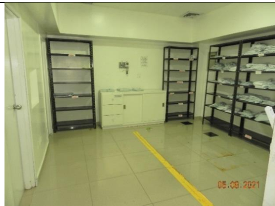
Clínica Unidos por la Vida, resanes de muros interiores, estuco y pintura, pintura de soportes metálicos
