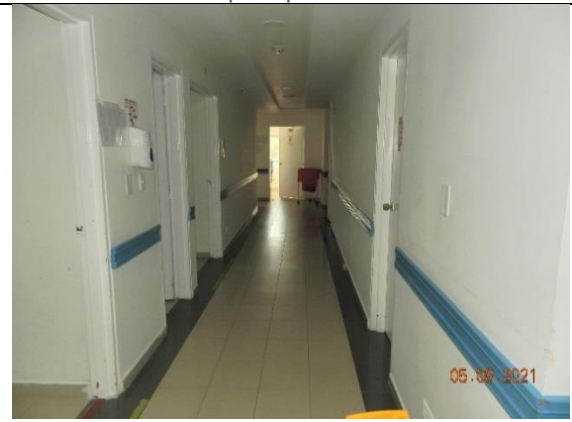
Clínica Unidos por la Vida, resanes de muros interiores, estuco y pintura en pasillos, pintura de puertas de madera, cambio de cerraduras para puertas de habitaciones
