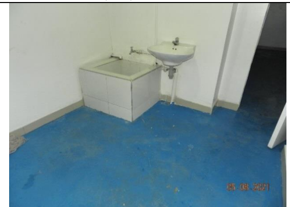
Clínica Unidos por la Vida, construcción lava trapeador en ladrillo enchapado
