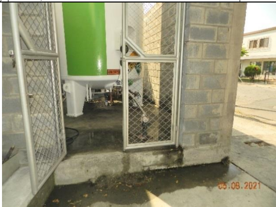
Clínica Unidos por la Vida, losa de concreto de cimentación, muro de cerramiento en bloques de concreto con refuerzo por dovelas, área exterior para tanque cryogas
