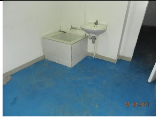
Clínica Unidos por la Vida, construcción lava trapeador en ladrillo enchapado
