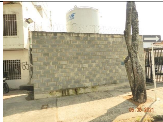
Clínica Unidos por la Vida, losa de concreto de cimentación, muro de cerramiento en bloques de concreto con refuerzo por dovelas, viga de amarre de muro en concreto reforzado, viga de amarre de muro en concreto reforzado, concertina sobre tubería galvanizada, área exterior para tanque cryogás.
