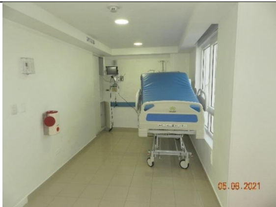
Clínica Unidos por la Vida. resanes de muros interiores, estuco y pintura, habitaciones, guarda escobas en cerámica piso-pared
