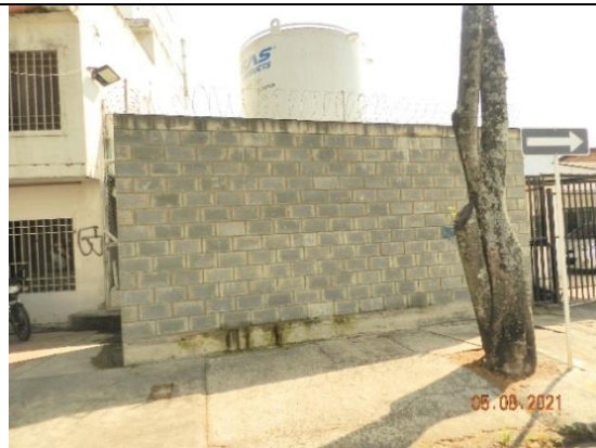
Clínica Unidos por la Vida, losa de concreto de cimentación, muro de cerramiento en bloques de concreto con refuerzo por dovelas, viga de amarre de muro en concreto reforzado, viga de amarre de muro en concreto reforzado, concertina sobre tubería galvanizada, área exterior para tanque cryogas.
