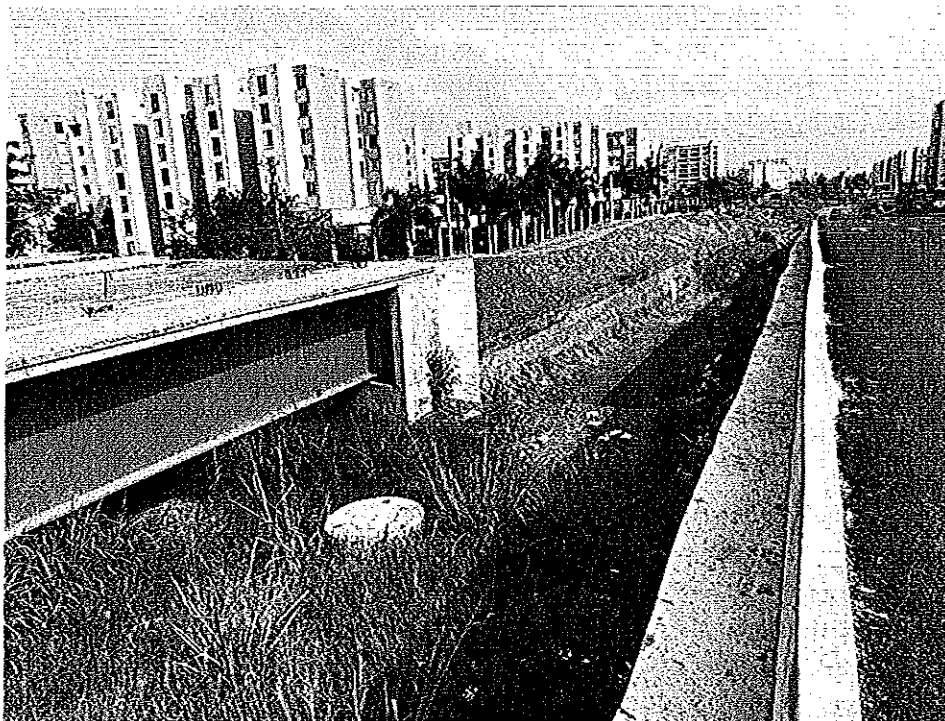
Imagen 2. Estructuras de puentes independientes con sentidos viales contrarios para facilitar la movilidad en sentidos Norte-Sur y Sur-Norte. Fuente: Propia
