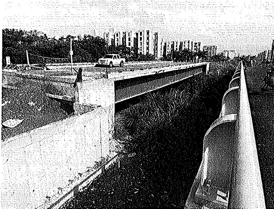
Imagen 1. Estructuras de puentes independientes con sentidos viales contrarios para facilitar la movilidad en sentidos Norte-Sur y Sur-Norte. Fuente: Propia
