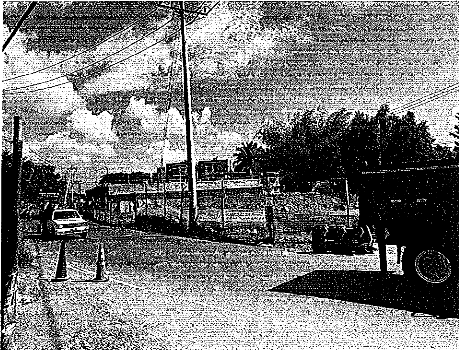
Imagen 3. Tablero principal de puente vehicular sobre el Río Lili en la vía Panamericana, mejoramiento de vía existente para habilitarla como paso alternativo durante la construcción de las estructuras de las rampas norte y sur del mismo. Fuente: Propia
