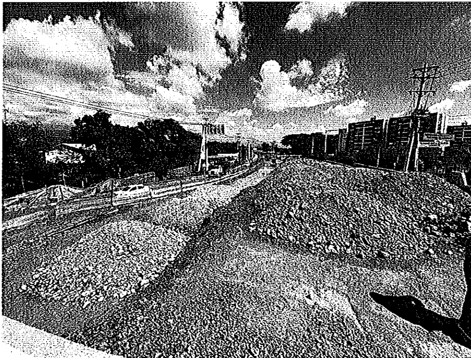
Imagen 4. Rellenos para estructura de rampa de acceso a puente vehicular sobre Río Lili en sentido Cali-Jamundí. Fuente: Propia
