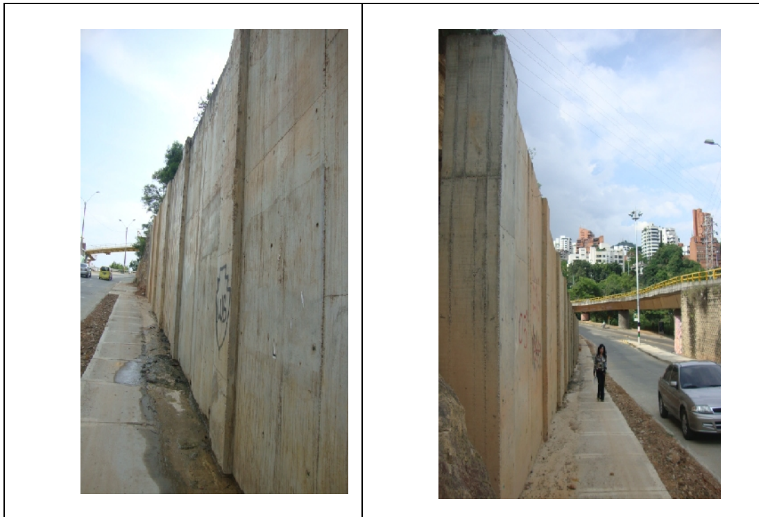
Construcción del muro reforzado
