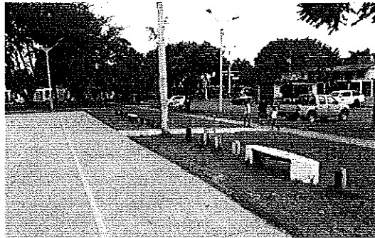
Bancas tipo Mío y cesto de basura el cual se lo han llevado, solo está la base para el cesto.
