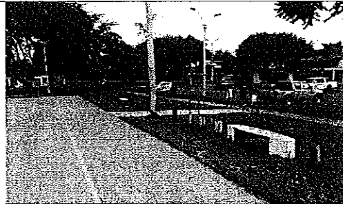
Bancas tipo Mio y cesto de basura el cual se lo han llevado, solo está la base para el cesto.
