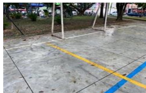
Fisuras en losas de concreto tratadas previamente y mapeo con nuevas fisuras por retracción de temperatura
