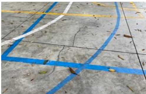
Fisuras en losas de concreto tratadas previamente y mapeo con nuevas fisuras por retracción de temperatura
