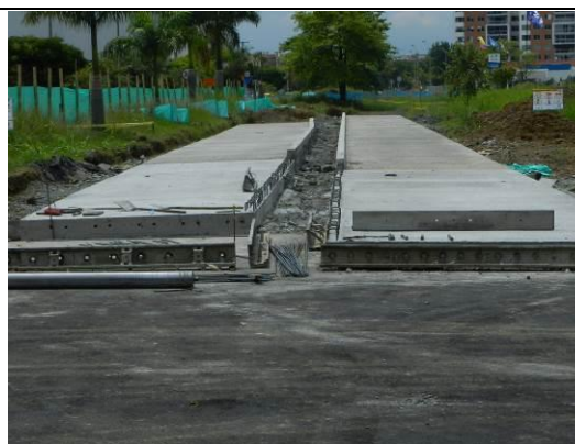
Puente Vehicular Carrera 100 Calle 25. Estructura de pavimento rígido en carrera 99 corredor troncal del MIO, en continuidad a la estación de parada Valle del Lili.
