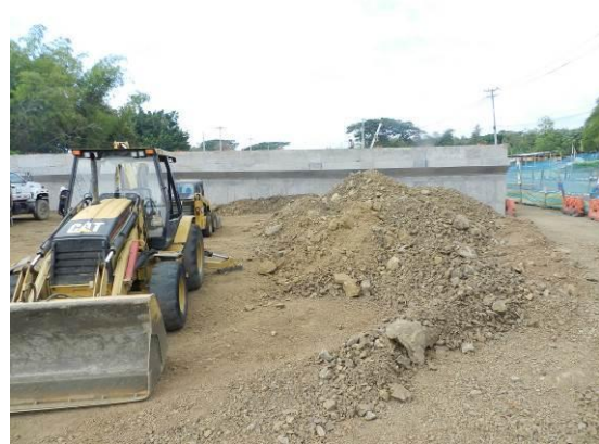
Puente vehicular río Lili. Relleno con material importado para los accesos
