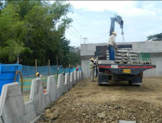
Puente vehicular río Lili. Relleno para los accesos, suministro e instalación de escamas prefabricadas en concreto reforzado para muros en tierra armada
