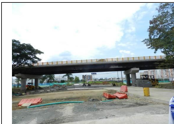
Puente Vehicular Carrera 100 Calle 25. Estructura de pavimento rígido en carrera 99 corredor troncal del MIO.
