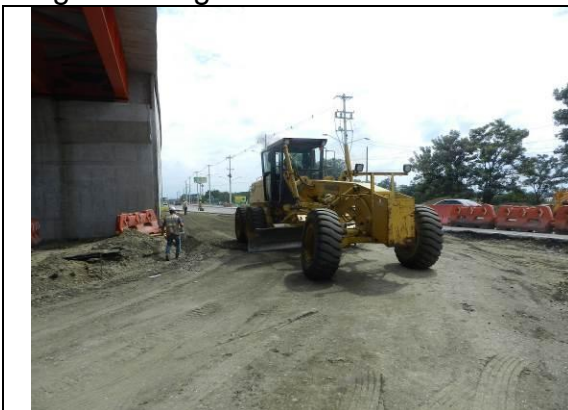
Vía Cali Jamundí Carrera 122. Conformación de base granular para colocación de la carpeta
