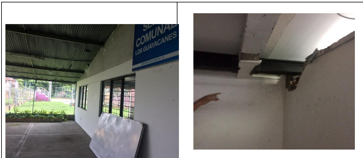
Imagen 2. Fachada y muro al interior con daño por instalación de estructura metálica
