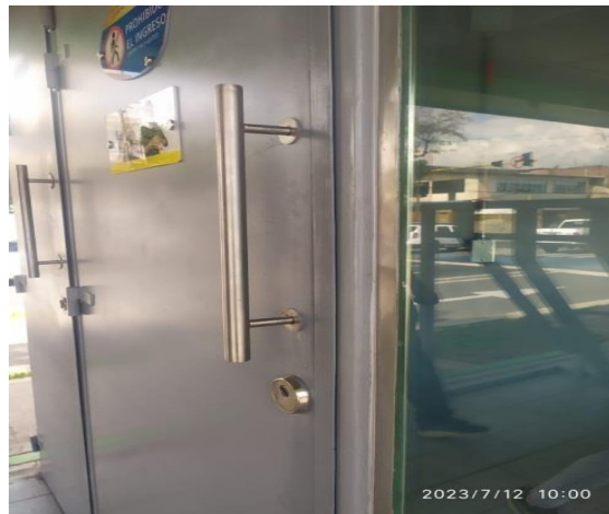
Foto 4. Estación 19 – Puerta Modulo de Taquilla.
