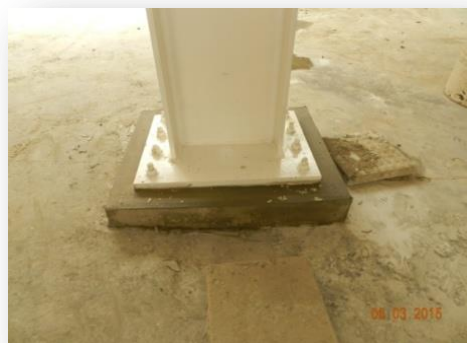
Anclaje de columna metálica sobre dado de cimentación
