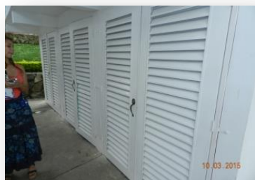
Deposito transitorio para la disposición de los residuos
