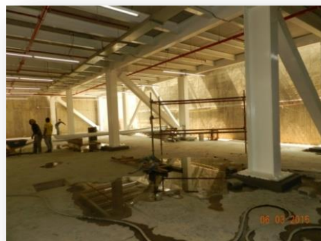
Estructura metálica, losa de entrepiso aligerada con viguetas metálicas, instalaciones hidráulicas, sanitarias y eléctricas
