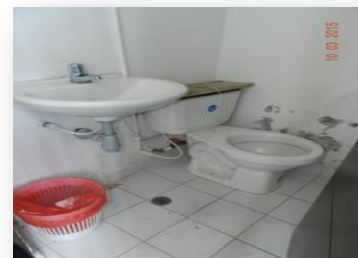
Baños ubicados en la sala de espera Urgencias
