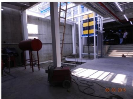
Estructura metálica, losa de entrepiso
