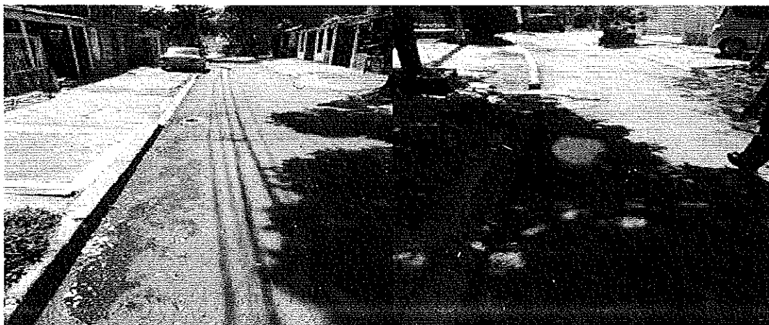
Fuente: Contraloría General de Santiago de Cali Imagen 2. Espejos de agua en algunos sectores de la vía carrera 23C
