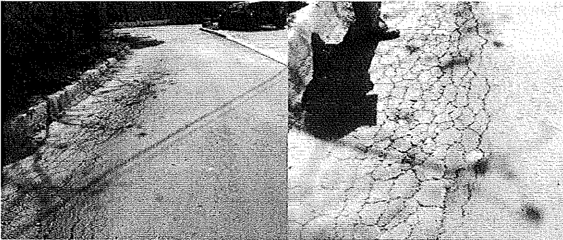
Imagen 3. Fisura y asentamiento de la vía en el sector de la calle 31 y carrera 23C
