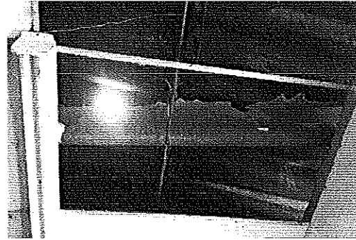
Tejas rotas que presentan goteras
